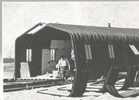
Le montage du bâtiment se fait par travées successives.
