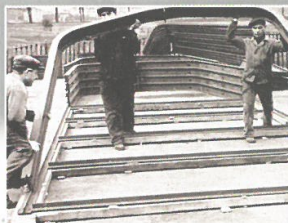
Les portiques sont montés au fur et à mesure.
