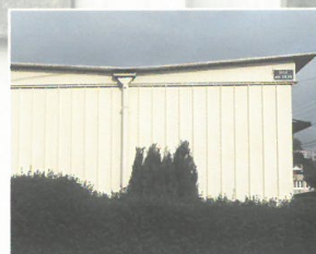
Les toitures peuvent être à 2 pans inversés.
