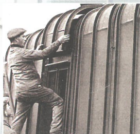
Des tôles faitières forment la toiture du bâtiment.
