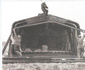
Des tôles faitières forment la toiture du bâtiment.
