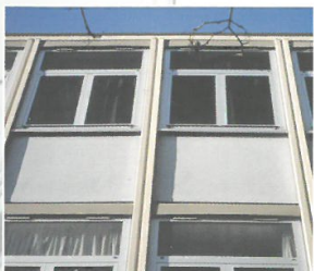
Photos : Façades des salles de classe du collège de Florange en panneaux sandwichs CL-T (Clément-Thébaud).
