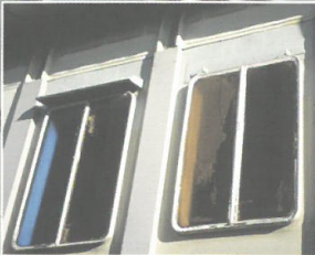
Dans le cas de chapelle, les chassis de fenêtres sont munis de verres teintés.
