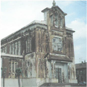
L'acier au cuivre, aujourd'hui appelé Corten ou Indatén, avait alors une oxydation non maîtrisée.
