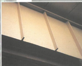
Les façades se composent de panneaux de tôle plissée.
