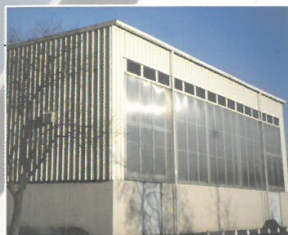
Gymnase de Thionville avec façade en bardage métallique et translucide.
