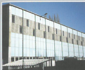
Gymnase de Florange avec façade en murs-rideaux de Bary et Rauzier.
